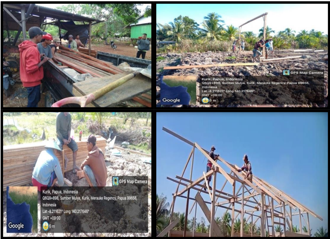
Gambar 5. Pembelian Bahan dan Renovasi Kandang
