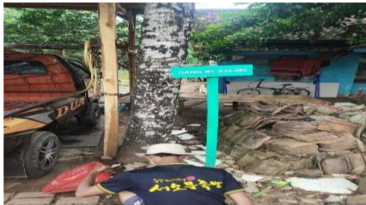
Gambar 1. Pemasangan Plang Jalan
