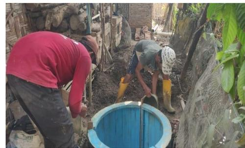
Gambar 12. Pemasangan cetakan
