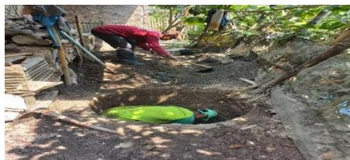
Gambar 9. Pembuatan lubang SPAL
