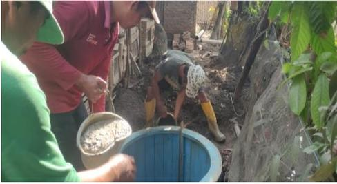
Gambar 13. Pengecoran SPAL
