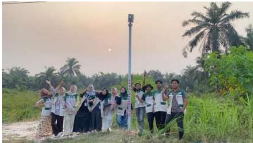
Gambar 1. Pemasangan PJUTS pada titik Rawah Lambat.
